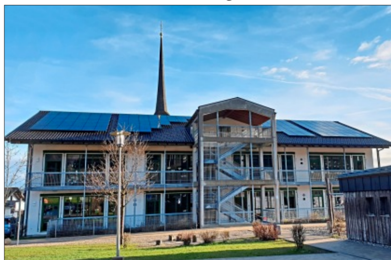
Die Photovoltaikanlage auf dem Dach sorgt für die Stromversorgung der Ober-teisendorfer Schule. – Foto: Monika Konnert
