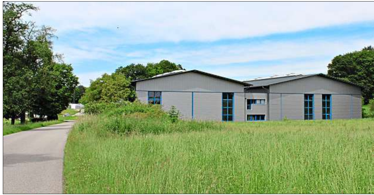
Das neue Gewerbegebiet Warisloh entsteht auf dieser Wiese rechts von der Straße im Anschluss an die bestehende Gewerbehalle. – Foto: Mergenthal
